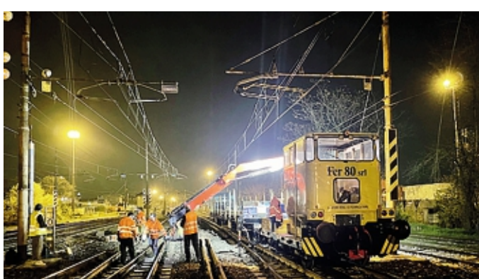
Il lavoro in cantiere per la manutenzione delle linee
